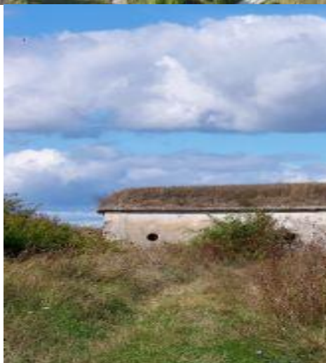
Piątnica, gm. Piątnica. Zespół fortów ziemno-betonowych. Fort I.
