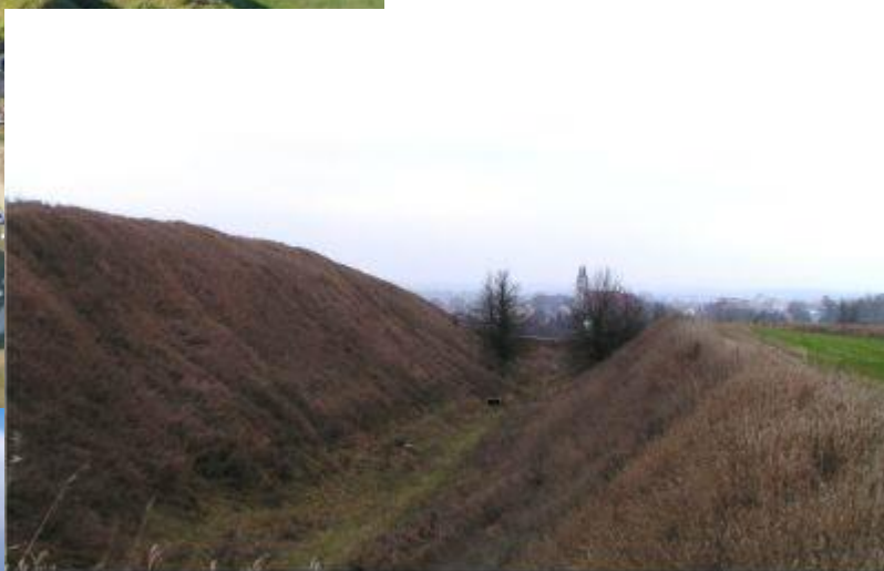
Piątnica, gm. Piątnica. Zespół fortów ziemno-betonowych. Fort I.
